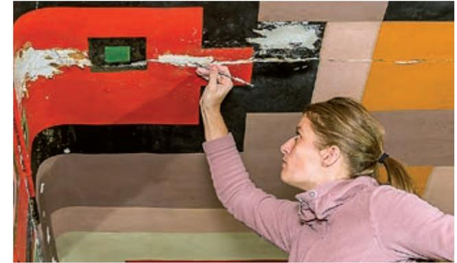
Nach der Freilegung wurden Putz und Malschichten gesichert, Risse gekittet und Fehlstellen retuschiert. Die originale Patina blieb erhalten.
